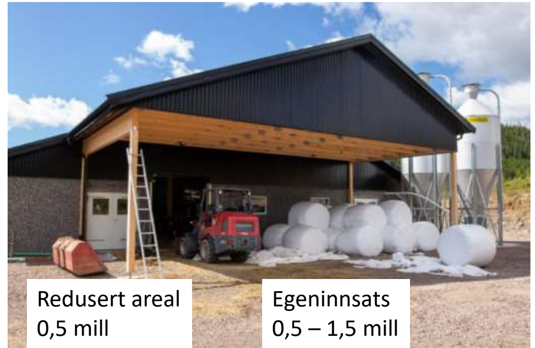
Førsentralen er bygd på utsida av fjøset ved at taket er strukket ut. Det foreligger planer om å kle veggene for å hindre at snøen føyer inn. Utfôringa skjer per nå med kompaktlaster. Foto: Morten Livenengen
